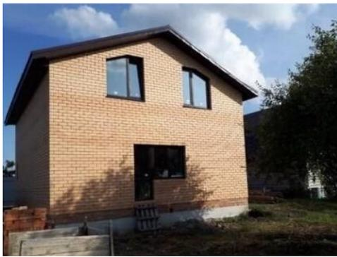
протиском. Фундамент ленточный шириной 50см, бетон 300 марки, на бурозаливных сваях. Стены из керамзитблока толщиной 300мм, утеплен пенопластом 100мм, облицован керамическим кирпичом. Перегородки в доме из керамзитблоков толщиной 12см. Окна пластиковые пятикамерные, тройной стеклопакет, цвет - темный дуб. Входная дверь российского производства, также имеется выход на
